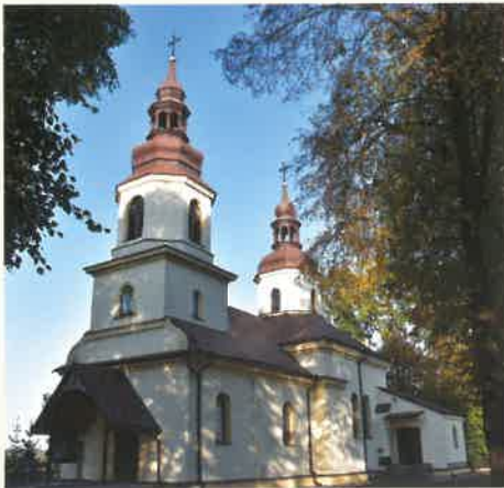
Kościół - dawna cerkiew prawosławna w Kalinówce (fot. K.W.)
